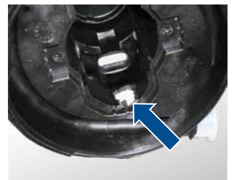
Картина повреждения: следы плавения на корпусе (вид сверху внутри корпуса)
