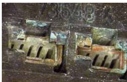
Złącze z wodą i śladami korozji
