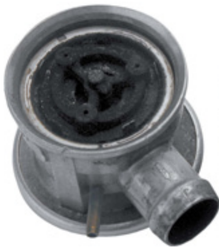
Poškození způsobené kondenzátem z výfukových plynů
