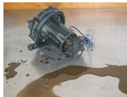
Tekutý kondenzát spalin z čerpadla sekundárního vzduchu
